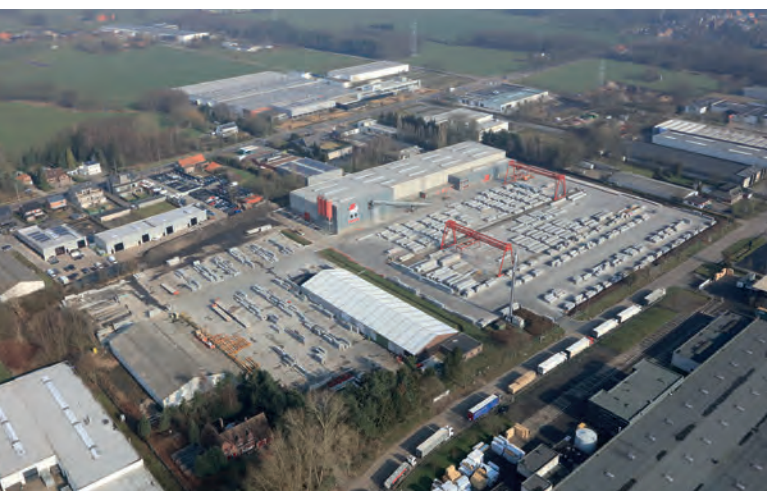
Vista aérea de la planta de producción de Fingo en Malle
