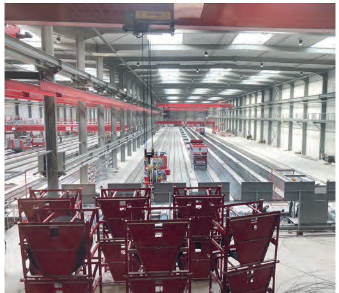
Nave de producción de la fábrica de Tessenderlo
