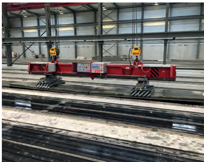
Elevación de las placas alveolares pretensadas con viga telescópica y grúa
